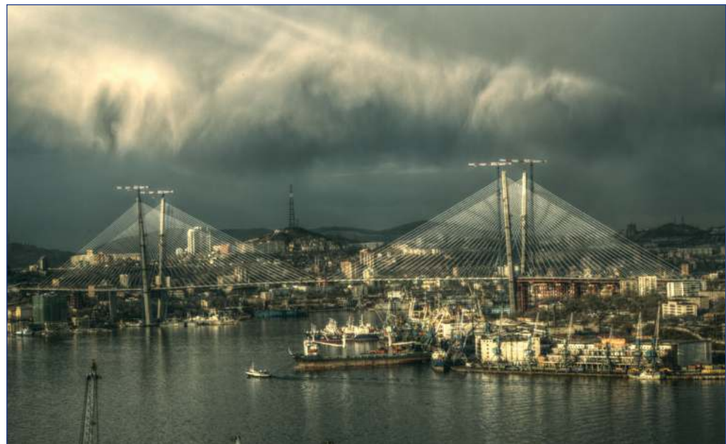
Владивосток. Мост через залив Золотой Рог. Фото А.В. Дында
