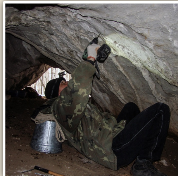
Сверление отверстий для троллея
