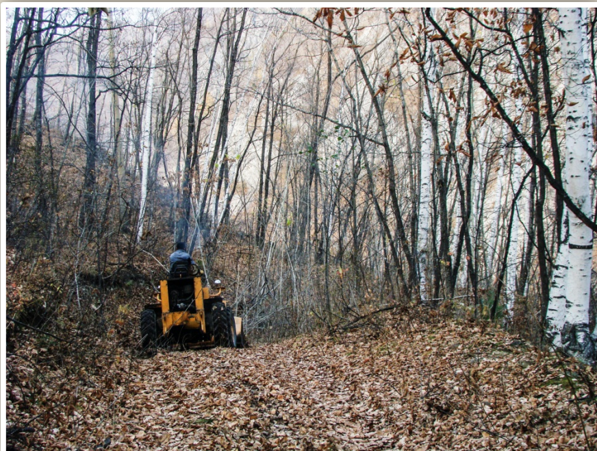
Расчистка дороги к пещере
