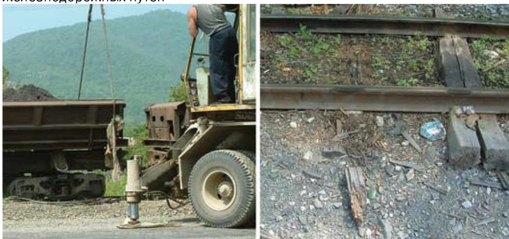
Рис. 26. Плохое состояние путей способствует просыпанию концентрата и сходу составов с путей
