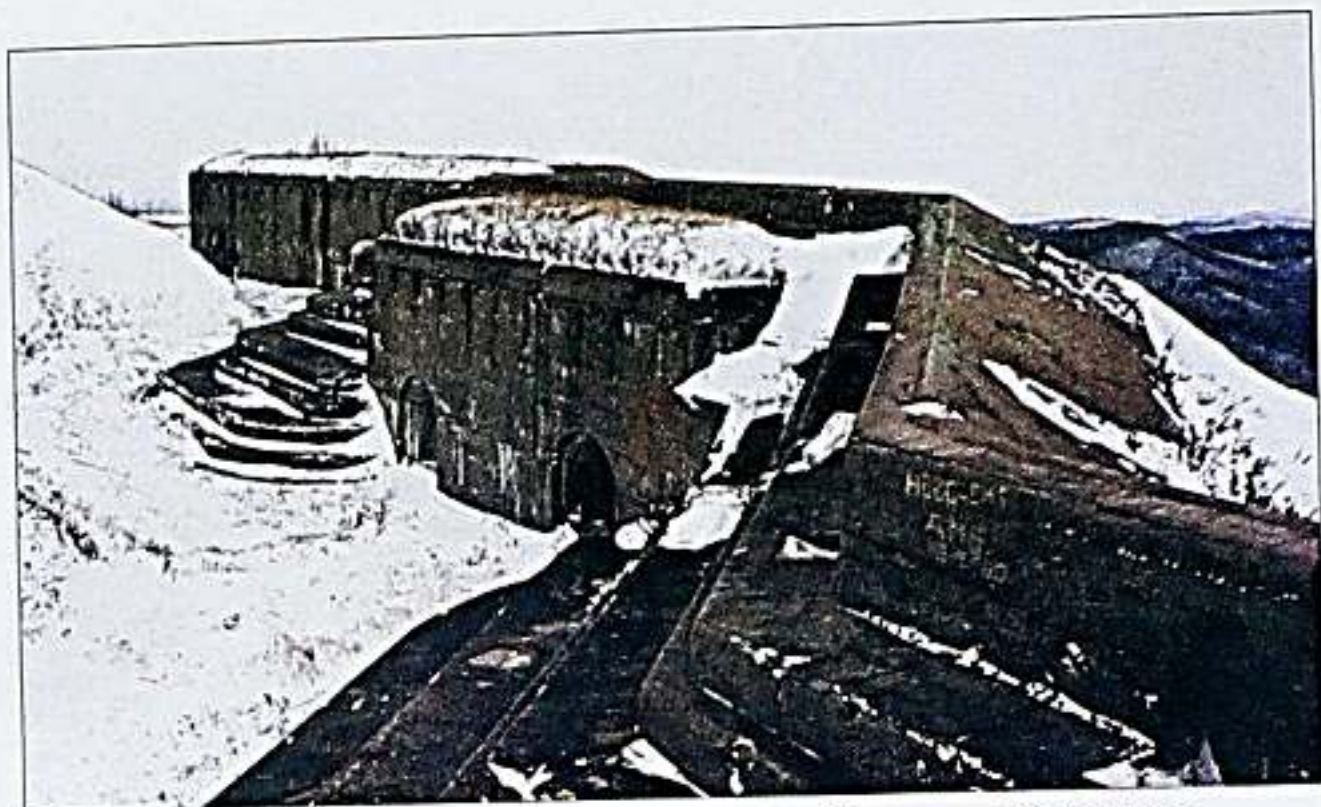
Форт № 4 Владивостокской крепости. Стрелковый бруствер и выходы из подбрустверной галереи
