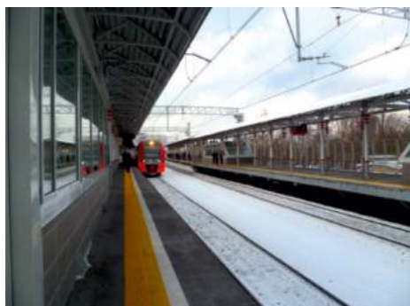
выход линии метро на поверхность
