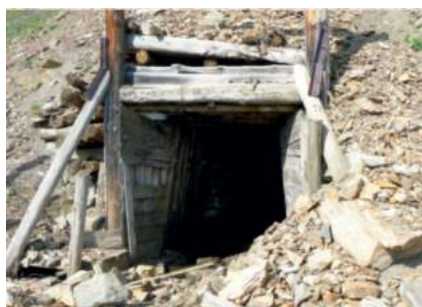
вход в штольню
