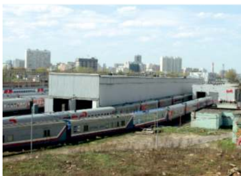
тупики и подъездные пути
