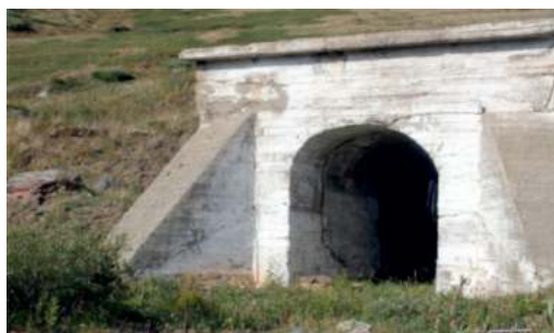
вход в штольню
