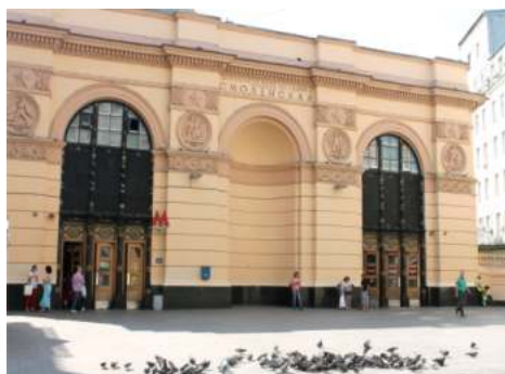
входы на станции
