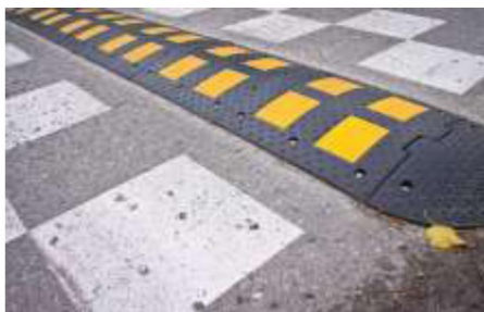
Рисунок 42 – Пример исполнения искусственной неровности сборно-разборной конструкции
