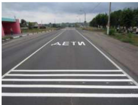
Рисунок 41 – Пример использования шумовых полос
