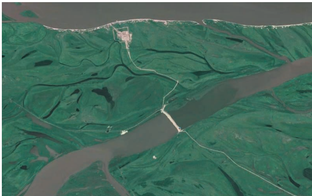
Рис. 4.6. Дамба, построенная китайцами на протоке Прямой между островами Большой Уссурийский и Тарабаров, перекрывающая проход воды из р. Уссури в Амур
