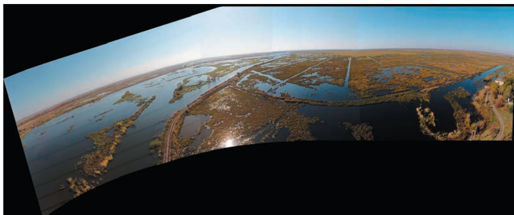
Рис. 2.33. Панорамный вид водных каналов, прилегающих к водно-насосной станции с. Новосельское, высота съемки 50 м
