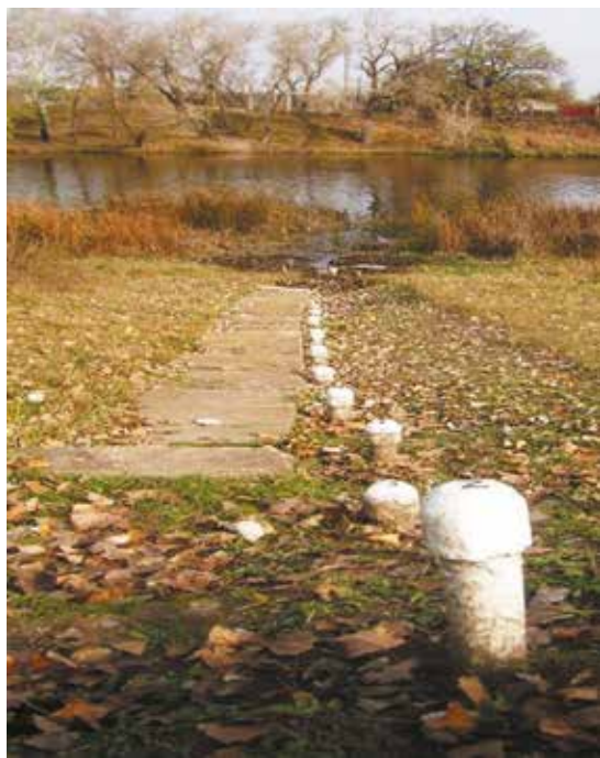
Рис. 1.76. Водомерный пост Росгидромета с винтовыми сваями
