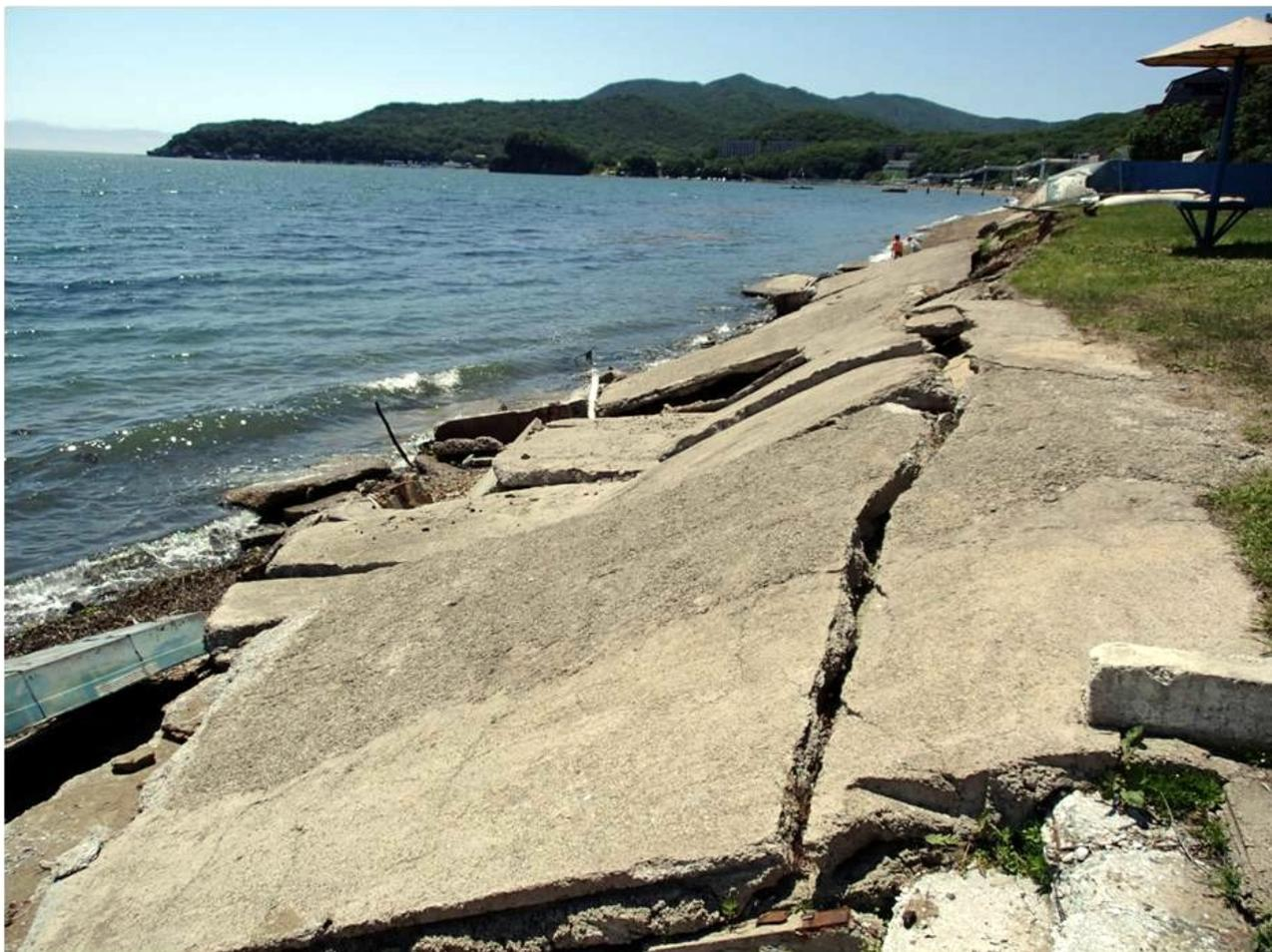
Рис. 5. Вид на аварийное состояние берегозащитных бетонных сооружений (фото В.В. Коробова).
