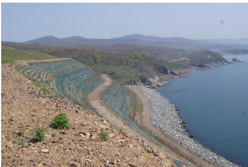
Рис. 12. Вид на восточный борт рекультивированного полигона
