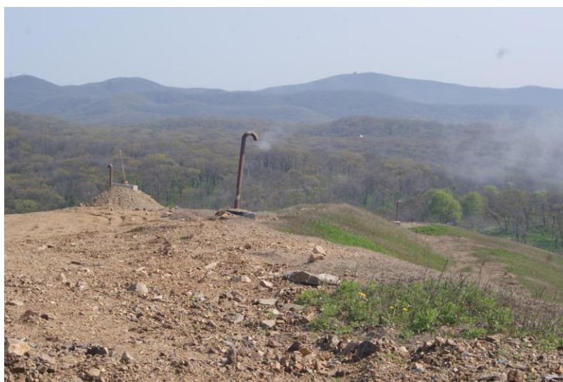
Рис. 10. Выделение газа из газодренажной скважины (как туман), май 2012 г.
