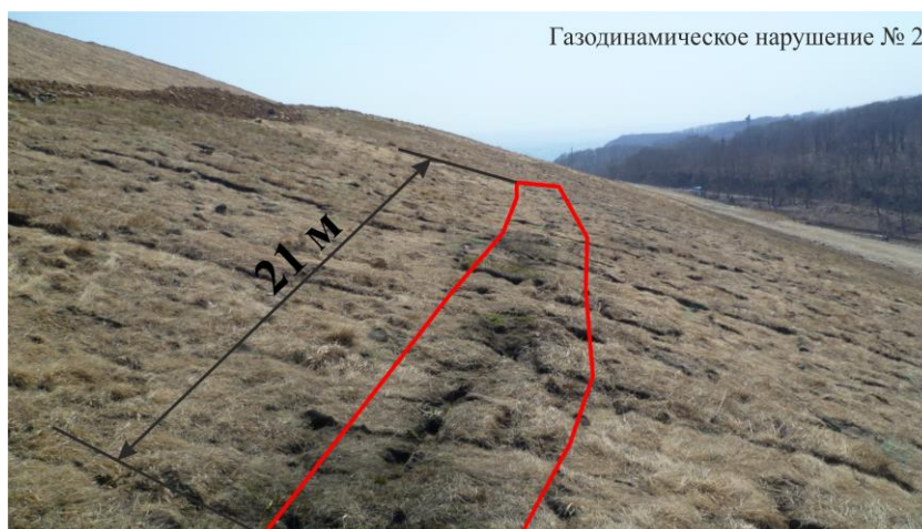
Рис. 9. Газодинамическое нарушение № 2. Западный борт полигона ТБО, 2011 г.
