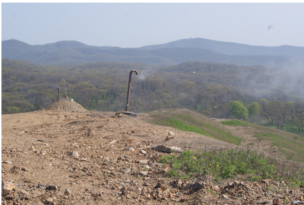
Рис. 10. Выделение газа из газодренажной скважины (как туман) в мае 2012 г. Fig. 10. Emission gas from degassing well (like fog) in May 2012
